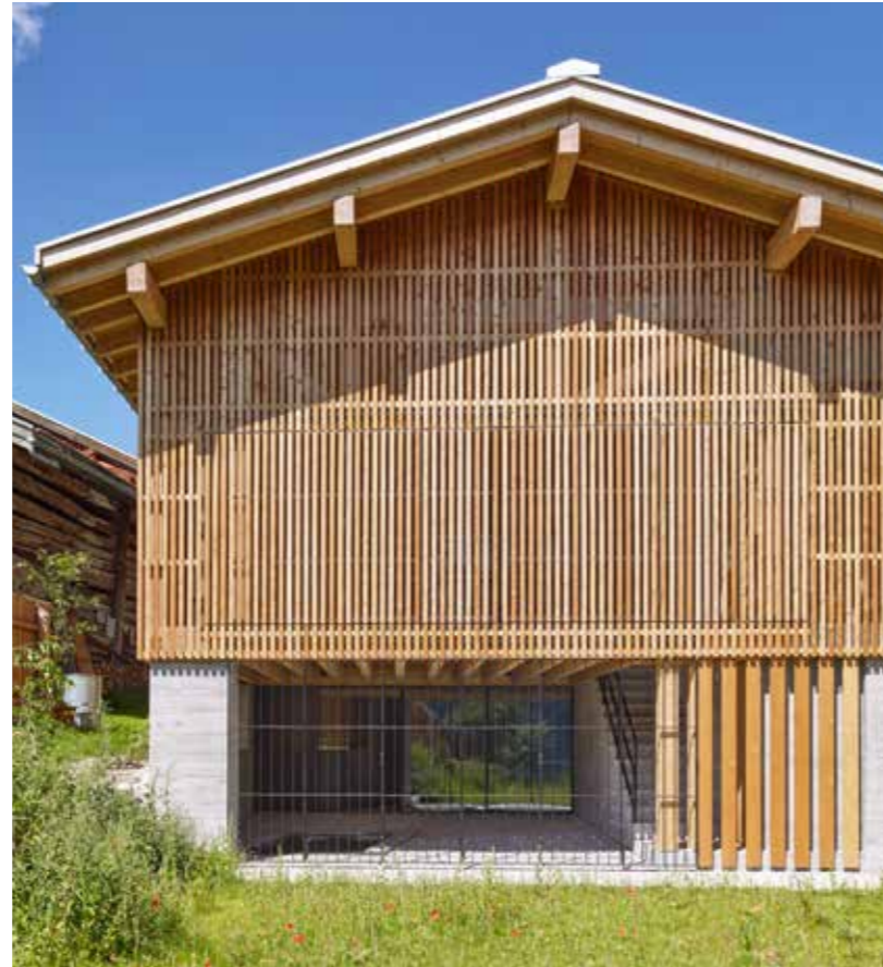
Semitransparent: Mit der lichtdurchlässigen Lärchenholzfassade der Loggia werden die ehemalige Scheune und ihre Lichtverhältnisse auf neue Art interpretiert, wohingegen die perforierte Metallverkleidung aus Aluminiumblech die starke Horizontalität der Bandfenster in den Bürogeschossen durchbricht sowie die funktionalen Lochfenster der Lagergeschosse kaschiert.
