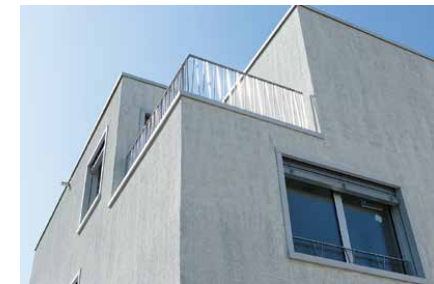
Der helle, grobe Fassadenputz wurde mit einem zweiten, dunkleren Anstrich versehen. Dieser zweite Anstrich wurde mit einem harten Roller so aufgebracht, dass ein Rindenmuster entstand.
